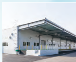
春日井工場 Kasugai factory
